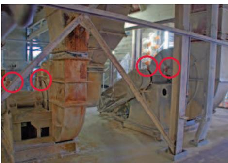
Los equipos de ventilación se suelen utilizar en **condiciones de aplicación extraordinarias**. Las materias extrañas, como polvo o medios de bombeo, son arrastradas y pueden penetrar en el sistema de cojinetes. Esto provoca un aumento del desgaste de los componentes individuales y una reducción de la vida útil.
